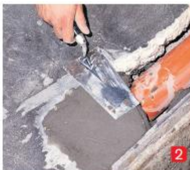
2) fixace kanalizace a kanalizační víka
