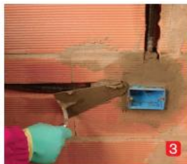
3) fixace elektrických krabic
