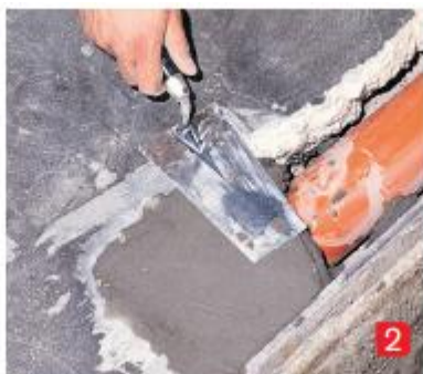
2) fixace kanalizace a kanalizační víka
