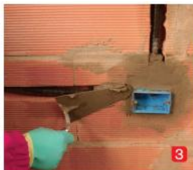
2) fixace kanalizace a kanalizační víka
