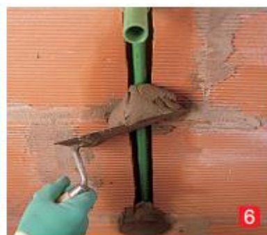
6) fixace vodovodních potrubí
