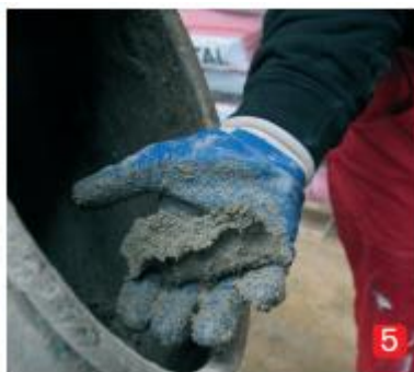
5) Zkouška konzistence hmoty „zavhlý potěr“.
