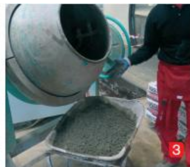
3) Příprava hmoty v míchačce.
