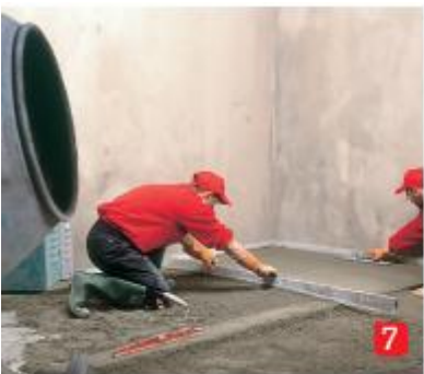
7) Nanášení pomocí podélných pruhů.
