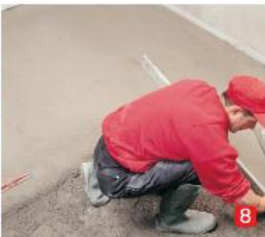
8) Pokládání a hutnění hmoty.
