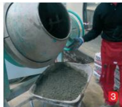
3) Příprava hmoty v míchačce.
