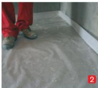
2) Aplikace expandovaného materiálu podél obvodu stěn. Položení vrstvy polyetylenu v případě plovoucího potěru.
