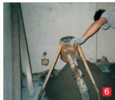
6) Doprava směsi pomocí čerpadla na betony.
