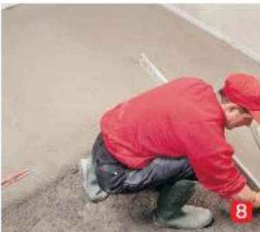
8) Pokládání a hutnění hmoty.
