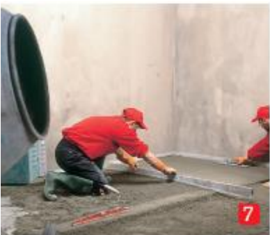
7) Nanášení pomocí podélných pruhů.
