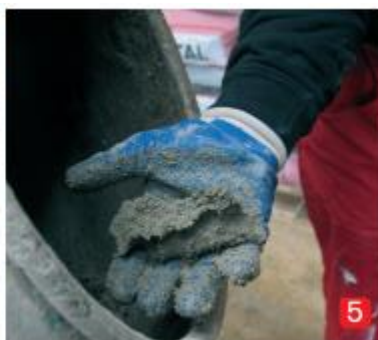
5) Zkouška konzistence hmoty „zavhlý potěr“.
