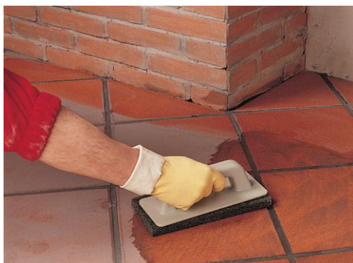
3) Po započetí tvrdnutí očistěte povrch hrubou vlhkou houbou
