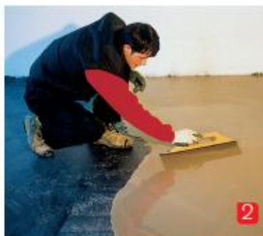
2) Roztažení rovným hladítkem
