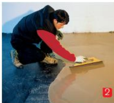
2) Roztažení rovným hladítkem
