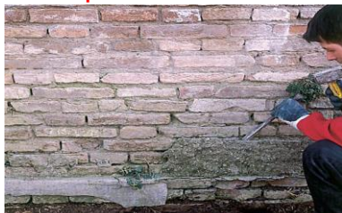
1) Odstraňte starou omítku do výše 1 m nad linii vlhkosti, obnažte zdivo až na cihlu
