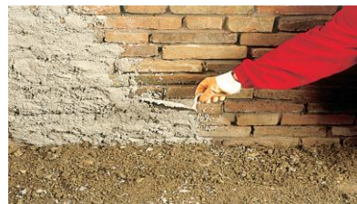
3) V případě výskytu silného výkvětu naneste celistvou vrstvu ADESAN RINZAFFO
