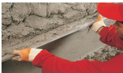
4) Strhněte sanační omítku ADESAN na tloušťku alespoň 2 cm
