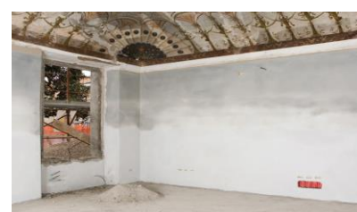
6) Naneste vrchní stěrku ADESAN RASANTE (jemné zrnitosti)
