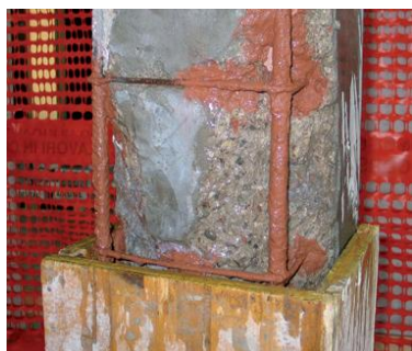
4) Umístěte formy a navlhčete podklad vodou
