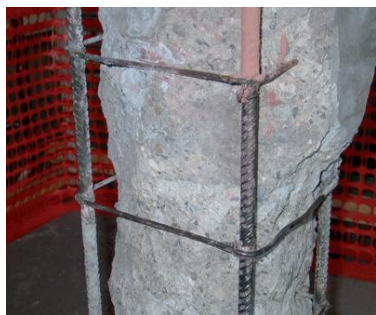
1) Odstraňte nesoudržné části
