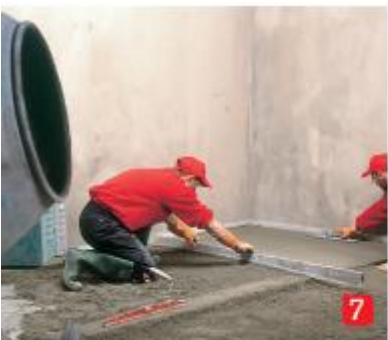
7) Nanášení pomocí podélných pruhů.
