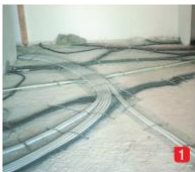
1) Preventivní aplikace lehké kovové sítě na místa průchodu trubek.
