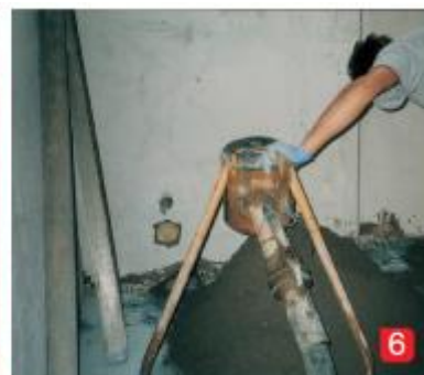
6) Doprava směsi pomocí čerpadla na betony.
